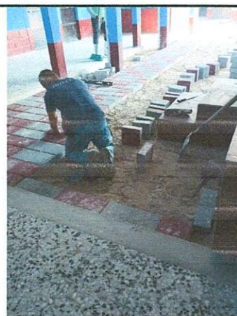
Foto 4: Avance en Mejoramiento E Instalación De Piso En Corredor Y Entrada Del Establecimiento Educativo.
