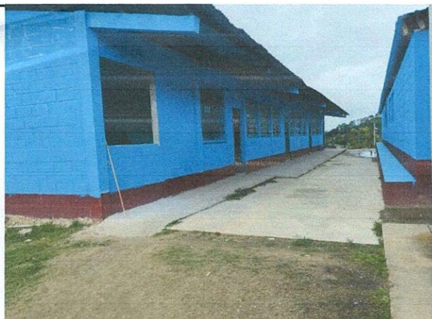
Foto 3: Avance en Instalación De Ventanas En El Aula Del Centro De Computación Con Una Medida De 1.70 De Ancho Por 1.50 De Alto Con Balcón De 1.75 De Ancho Y 1.65 De Alto.
